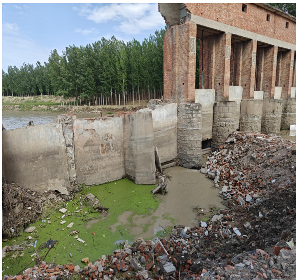
图 1-2 位庄节制闸左岸闸门现状
